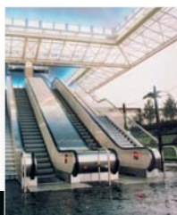
Nappe d'escalier mécanique
